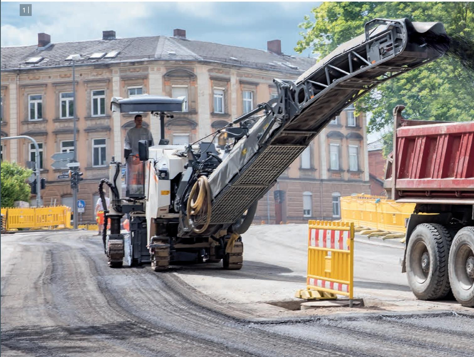
1 | Der große, beidseitige Bandschwenkwinkel sorgt für flexible Fräsgutverladung.
